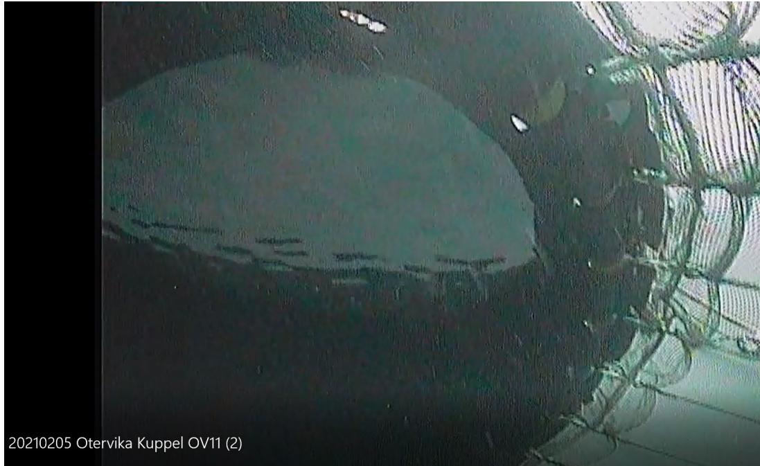
Figur 17 Vurdering av størrelse på luftlomme
