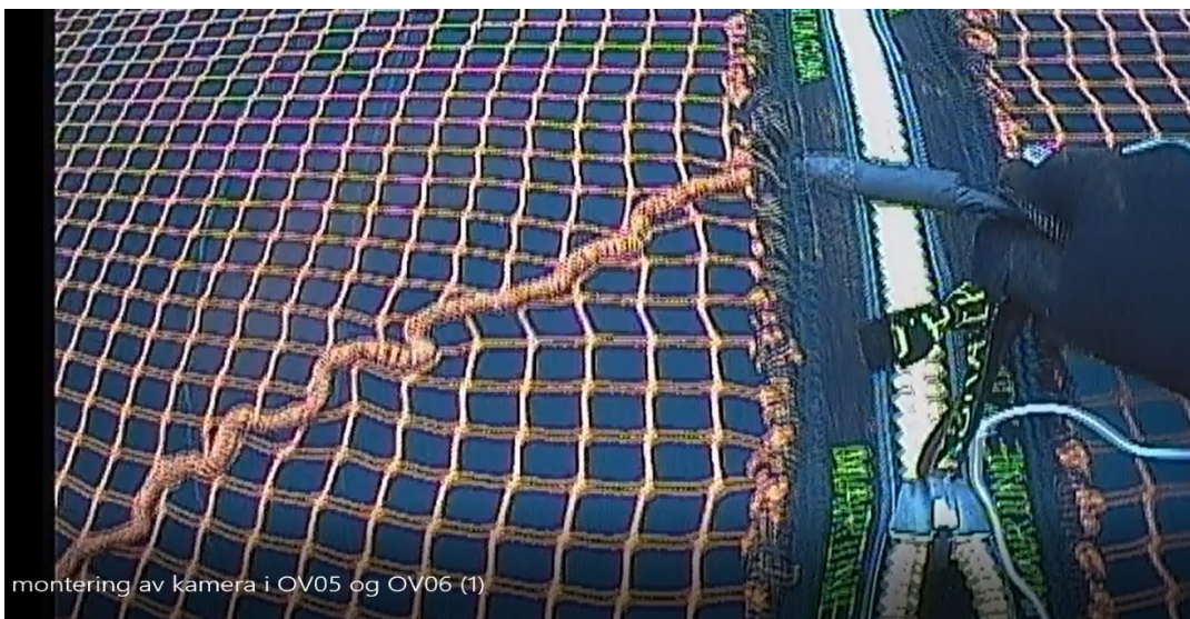
Dykker åpner glidelås i taket for å montere kamera
