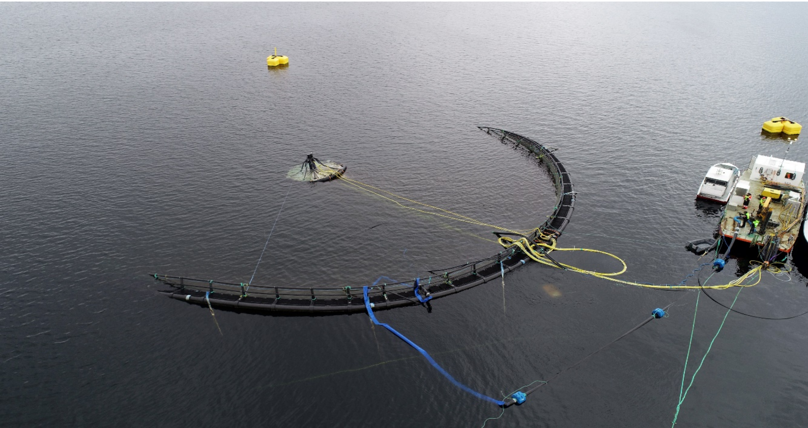
Senking av merd ved første utsett på Gjerdinga
